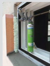
수원시 주택 PU033 시공현장
