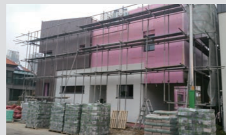
인천 논현동 PU033 외단열 시공현장
