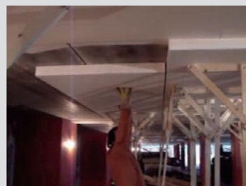
PU033 내부 단열재 시공장면
