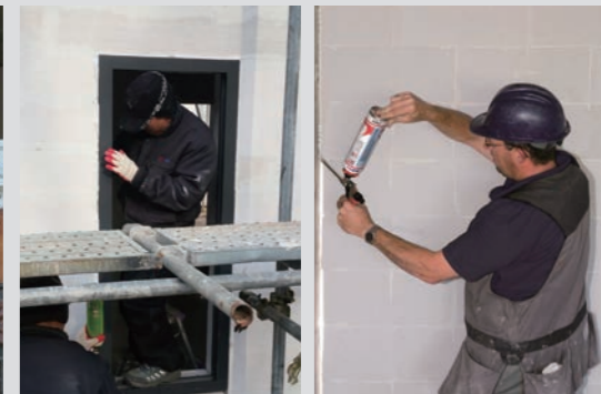
용인 금어리 ALC주택 건축현장 FM230 시공장면
