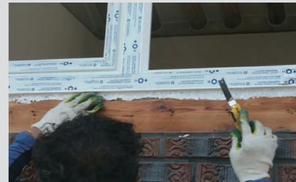
인천 목조주택 리모델링 현장 FM230 시공장면
