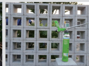
PU700 콘크리트블록 시공현장
